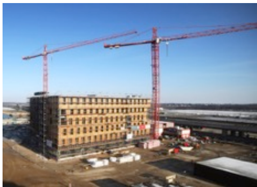
HoHo in Wien, Architecte Richard Wochitz
