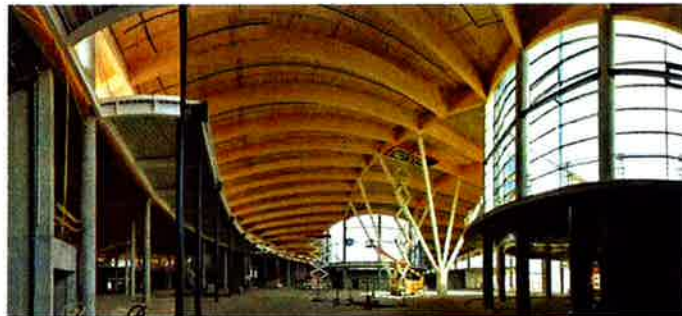
Innenansicht: die BSP-Platten sind bereits montiert Foto: Hannes Plackner/Holzkurier
