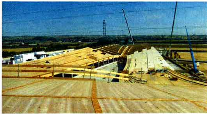
Hier sind die BSP-Platten mit OSB-Streifen schubsteif zu einer Scheibe verbunden Foto: Graf-Holztechnik GmbH
