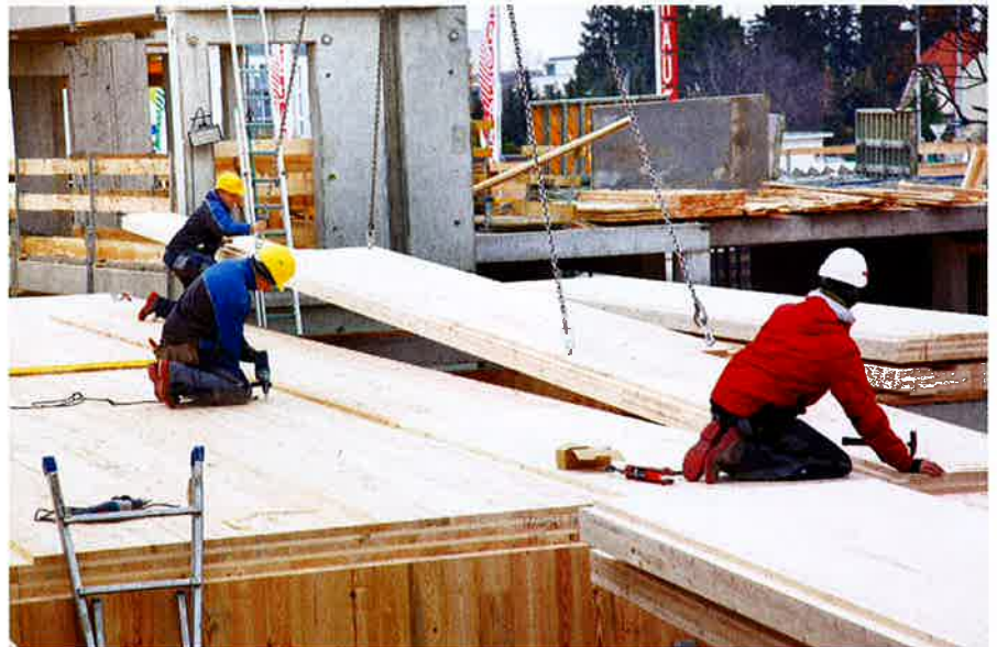
Die vorgefertigten Elemente für Österreichs höchstes Wohnhaus in Holzbauweise werden montiert.
