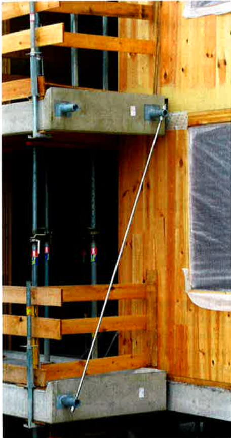
Abbildung 2: Verwendung von Betonfertigteilen, BVH Wagramer Straße
