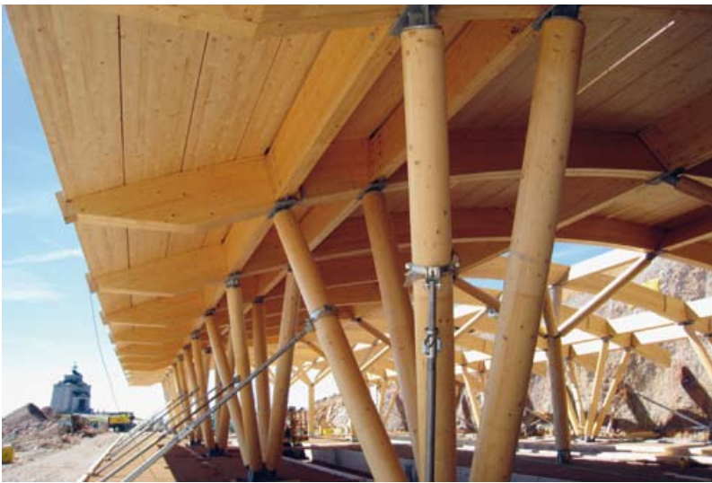
◀ Dachuntersicht der auf Fuge verlegten BS-Holz-Dielen
