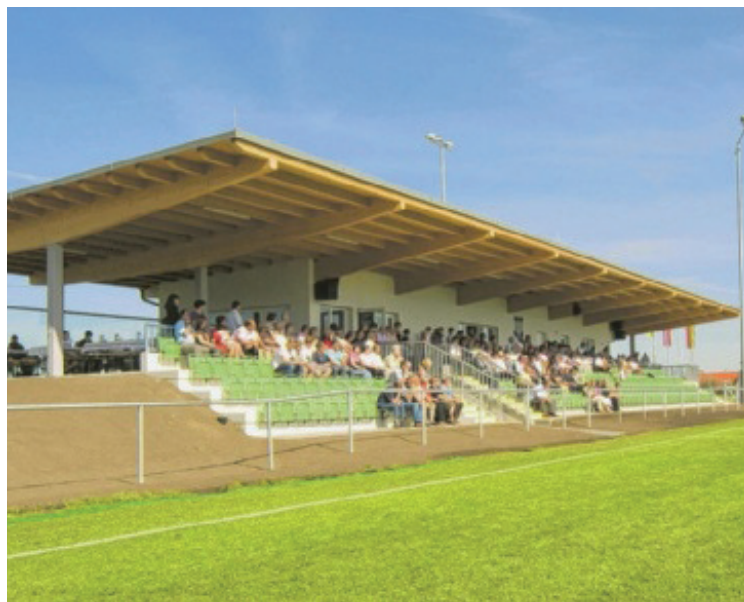
Der Betrieb der neuen Sportanlage ist energiesparend.
